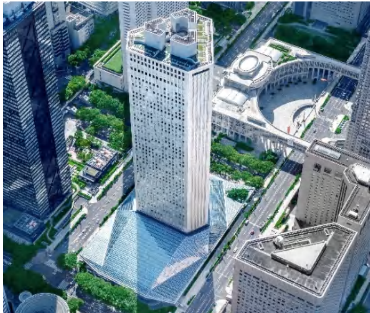
＜リニューアル後の新宿住友ビル外観＞
