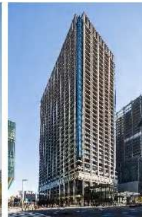
東京日本橋タワー
