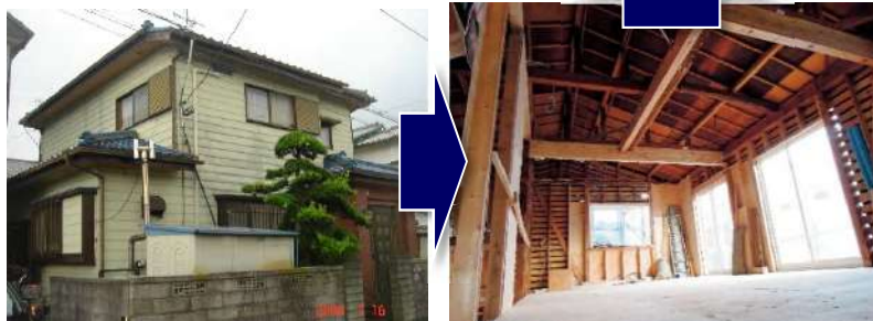
構造躯体などを残し、 スケルトンにして再生
