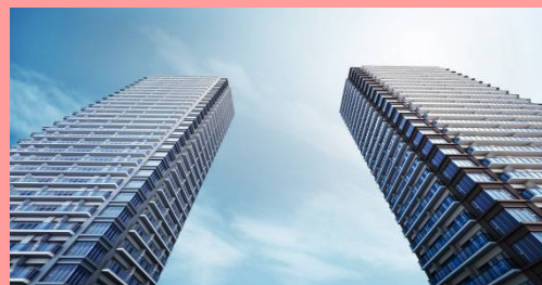
シティタワー国分寺ザ・ツイン
