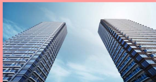
シティタワー国分寺ザ・ツイン
