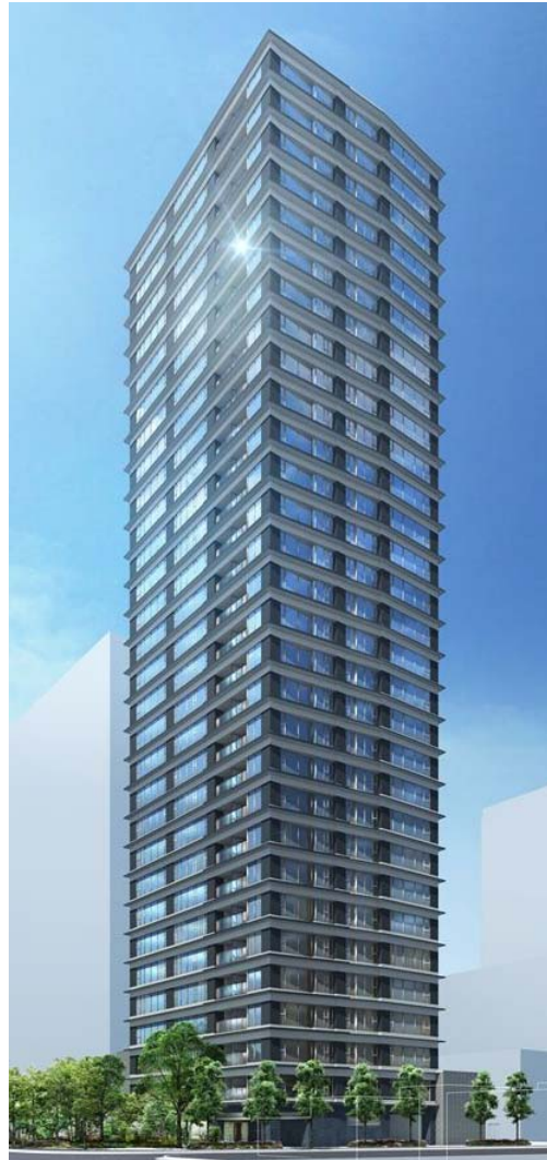
<東京ベイシティタワー>
