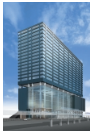
汐留住友ビル(H16/7竣工予定)
