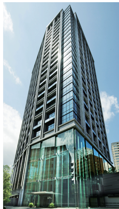
住友不動産麹町ガーデンタワー
