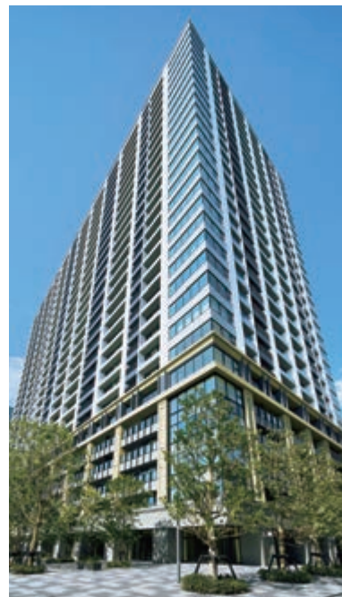
シティタワー大井町
