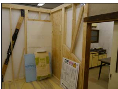
<工事中ゾーン>
