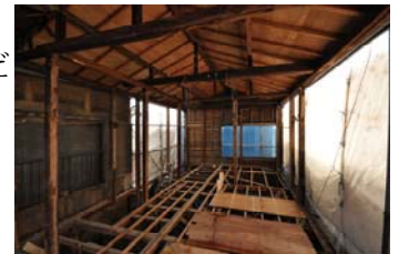
<活かせる資材を残して施工>
