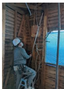
耐震補強工事の様子
