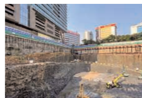
<BKC第1号案件>(地下掘削中)
