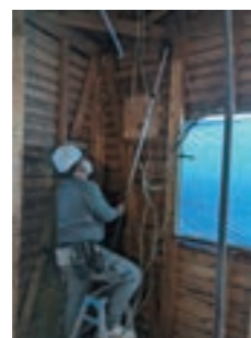
耐震補強工事の様子
