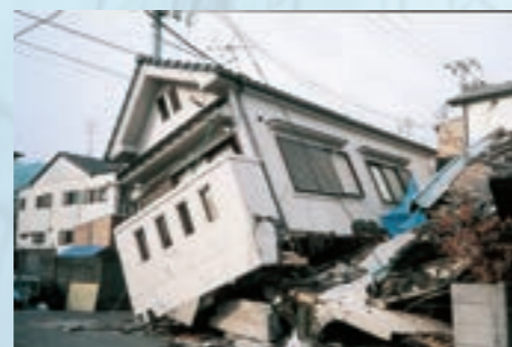
阪神・淡路大震災で倒壊した家屋 (宮澤健二教授撮影)
