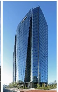
大崎ガーデンタワー
