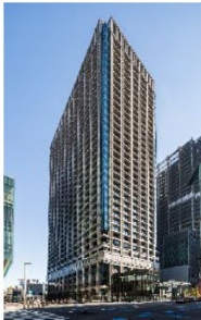
東京日本橋タワー
