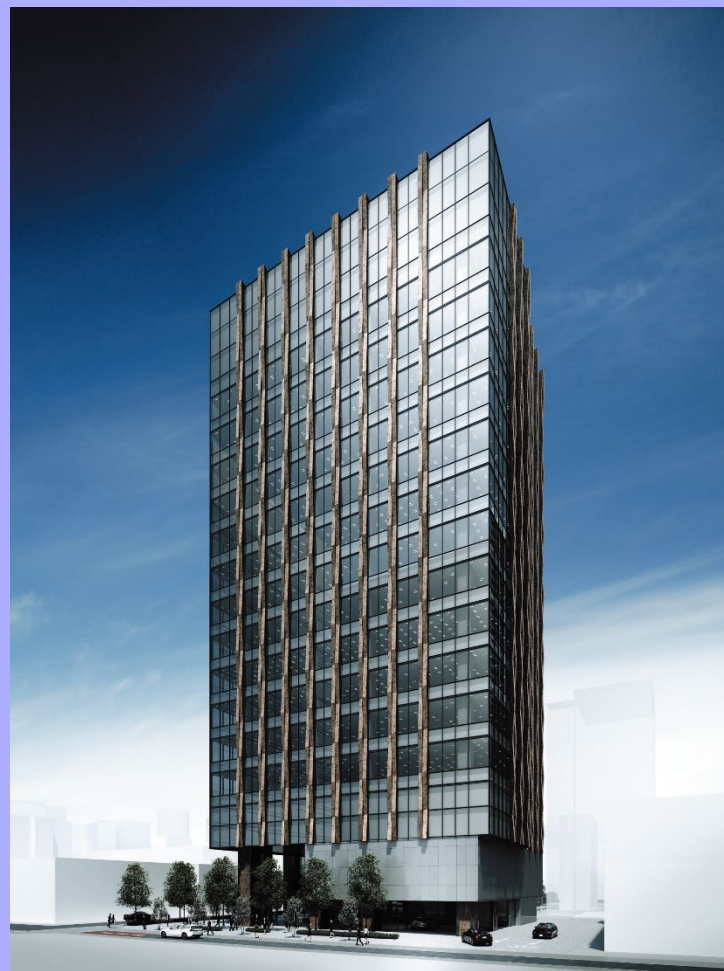
住友不動産大崎ツインビル西館
