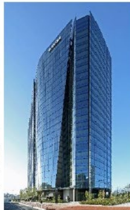
大崎ガーデンタワー
