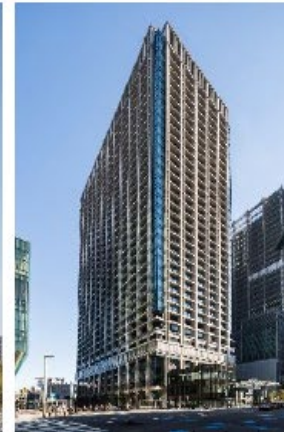
東京日本橋タワー
