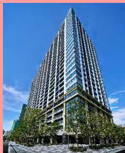
シティタワー大井町
