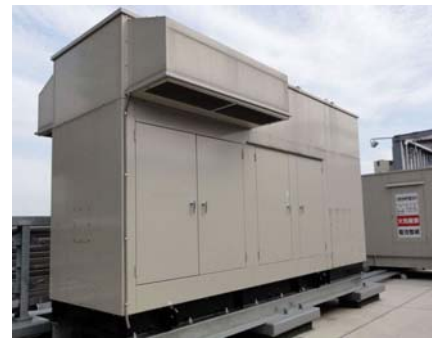
<非常用発電機・イメージ>
