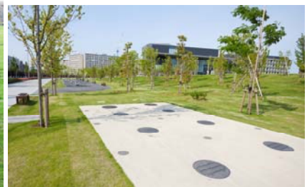
<マンホールトイレ>
