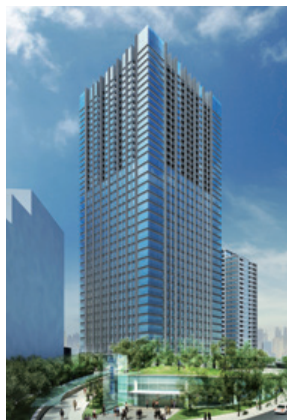
住友不動産新宿ガーデンタワー (平成28年3月竣工予定) 東京都新宿区 地上37階/地下2階 延床面積:139,000㎡
