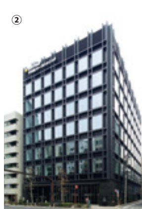
②住友不動産千代田ファーストウイング (平成26年1月竣工) 東京都千代田区・ 地上7階/地下1階 延床面積:8,888㎡
