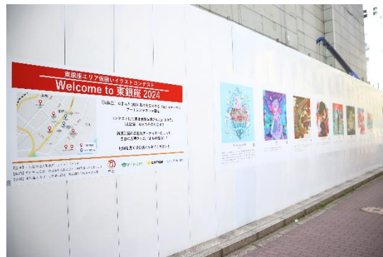
② 築地一丁目ビル解体工事現場
