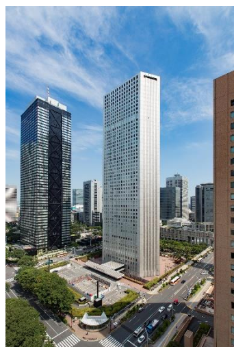
<2016年7月 改修工事前>
