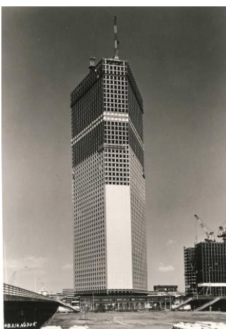
<建設中(1973年3月14日)>
