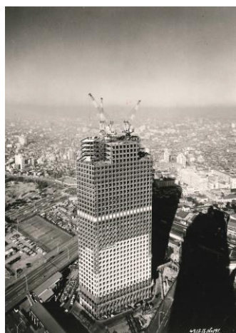
<建設中(1972年12月14日)>
