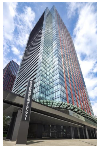
住友不動産東京三田ガーデンタワー 外観
