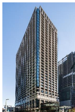
東京日本橋タワー
