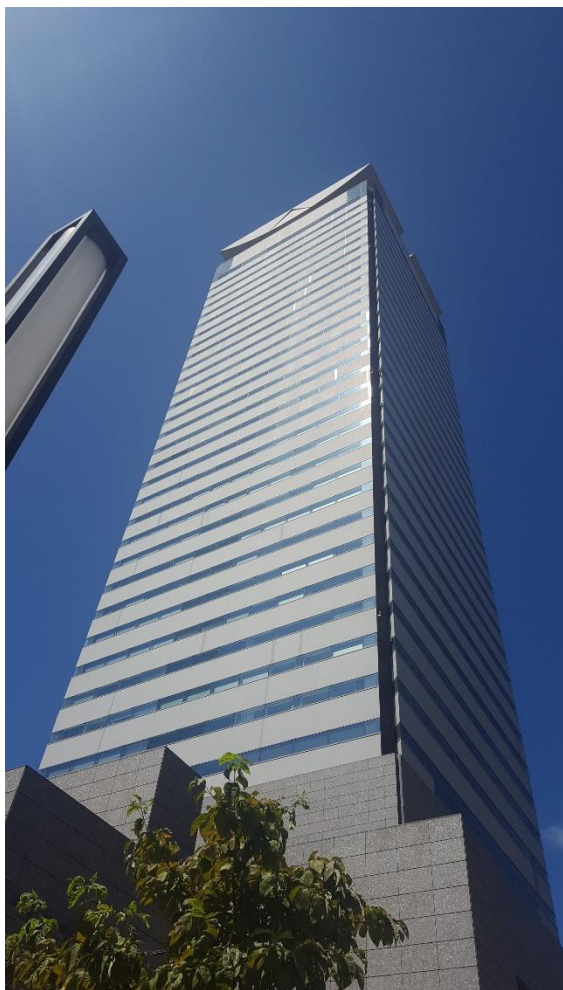
住友不動産虎ノ門タワー 外観
