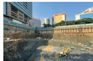
BKC 1号案件(地下掘削中)
