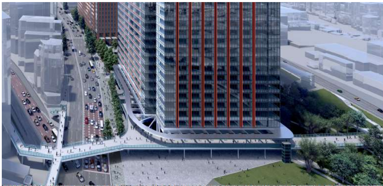
<田町駅側より望む歩行者デッキ>
