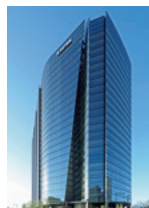
大崎ガーデンタワー
