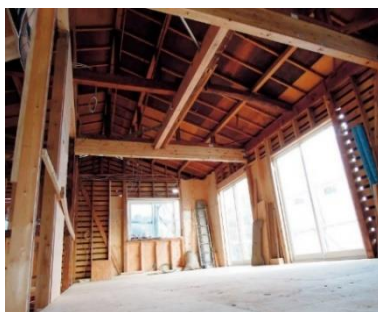
施工中(構造躯体まで解体した状態)
