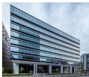
住友不動産田町ビル東館 (2021年4月竣工)
