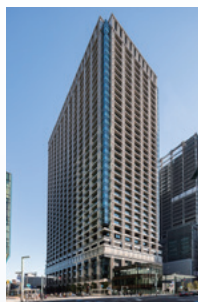
東京日本橋タワー
