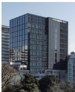
住友不動産御茶ノ水ビル (2021年1月竣工)
