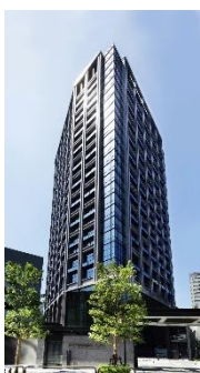
住友不動産 麹町ガーデンタワー
