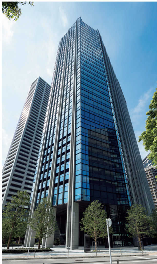
住友不動産新宿セントラルパークタワー (2019年8月竣工) 東京都新宿区 地上33階/地下2階 延床面積:60,093㎡
