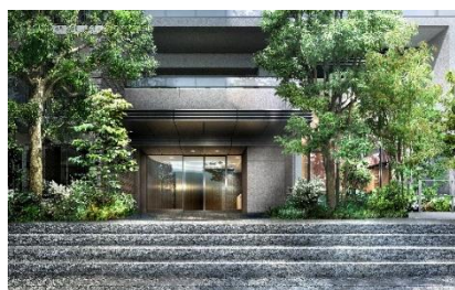
<エントランス(ザ・パーク)>
