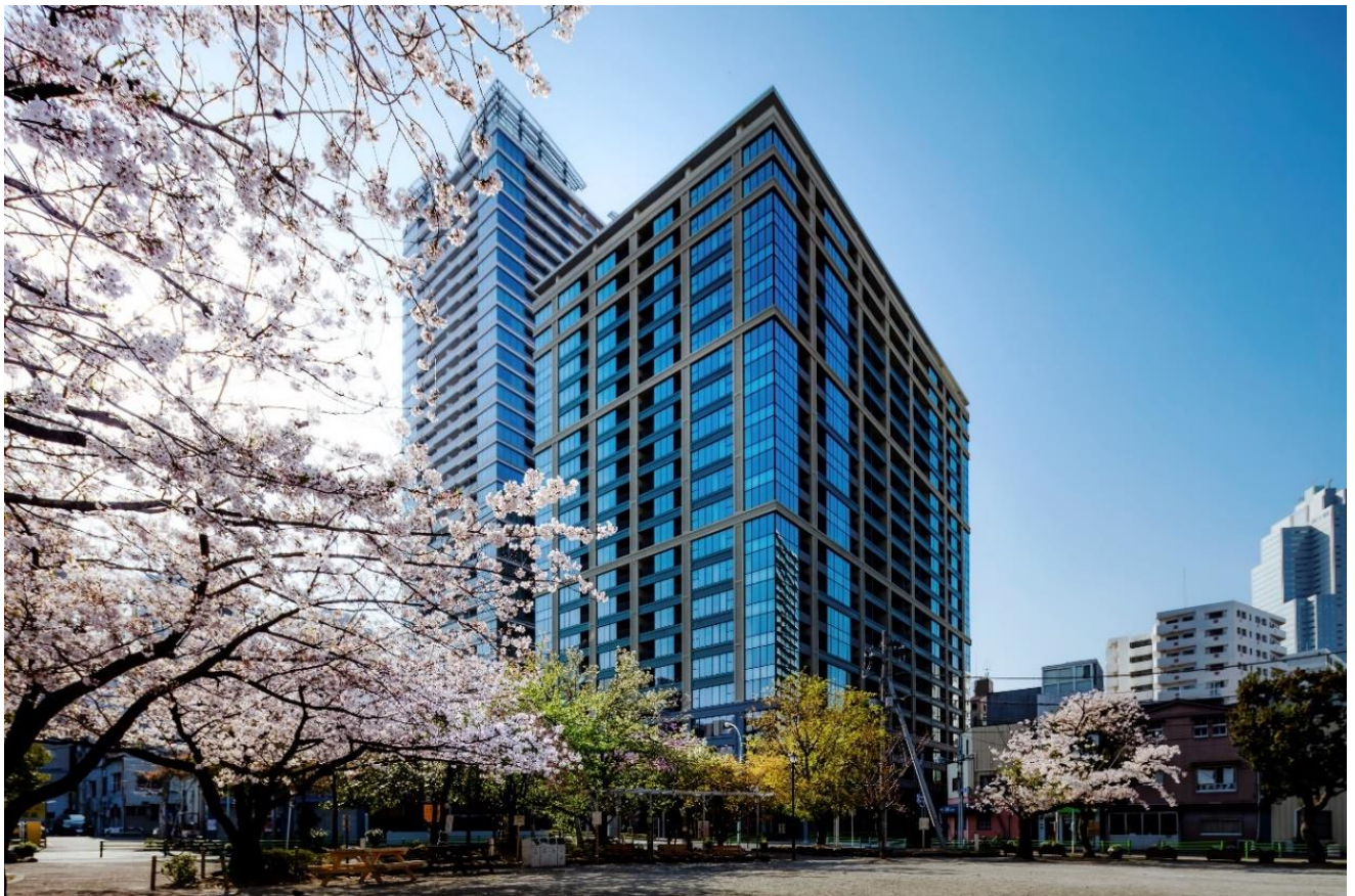
<外観完成写真>
