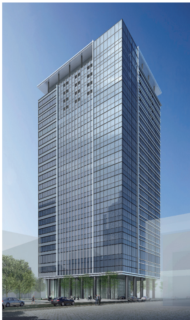
住友不動産渋谷タワー (2019年2月竣工)
