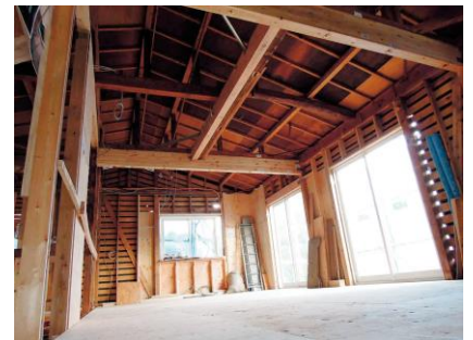
<施工中(構造躯体まで解体した状態)>
