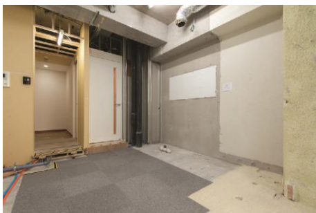
<解体工事中モデル>
