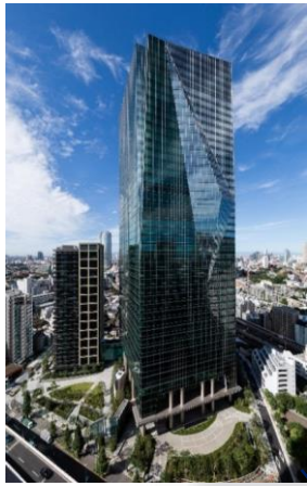
＜オフィス棟：住友不動産 六本木グランドタワー＞
