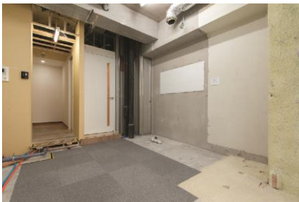
<壁、床を解体した工事中モデル>
