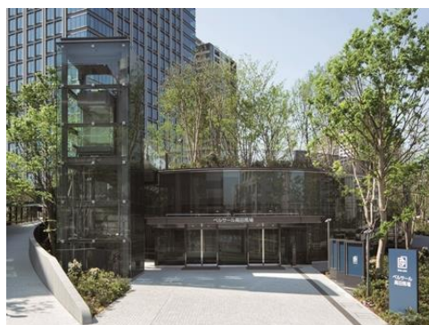
<ベルサール高田馬場エントランス>
