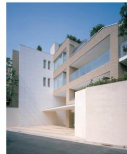
クラッシュハウス尾山台 (2009年竣工)
