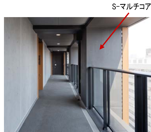
<施工例・シティハウス南品川>
