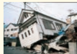
阪神・淡路大震災で倒壊した家屋 (宮澤健二教授撮影)
