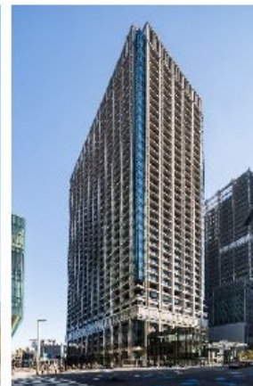
東京日本橋タワー
